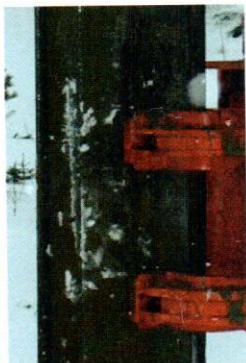
Рис. 9. Оси шпунта и Movax параллельны
