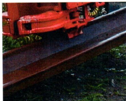
Рис. 3 Подъем при помощи 4-го захвата
