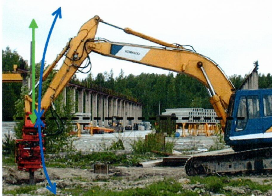
Рис. 23. Движение стрелы экскаватора при погружении шпунта
