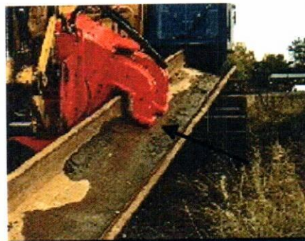
Рис. 4. Манипулирование шпунтом при помощи боковых захватов
