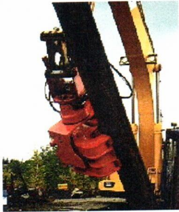
Рис. 12. Переместить шпунт подальше от кабины
