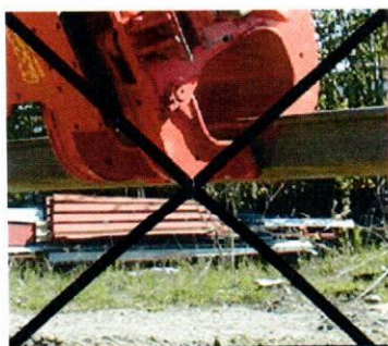
Рис. 5 Небезопасный прием захвата шпунта
